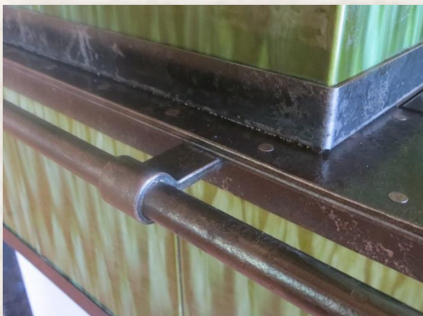
Herkranz genietet in geschmiedeter Oberfläche
