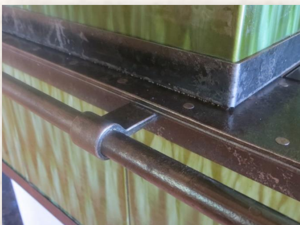
Herkranz genietet in geschmiedeter Oberfläche
